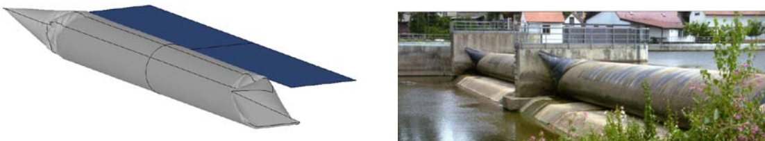
Bild 3: FE-Modell (links) und reales Schlauchwehr (rechts)
